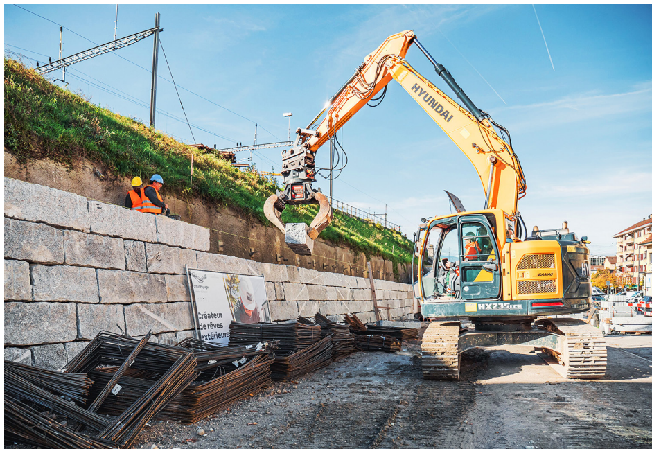
Travaux en cours dans le secteur Flumeaux-Confrérie (novembre 2022).
